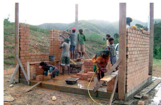
Montage de briques
