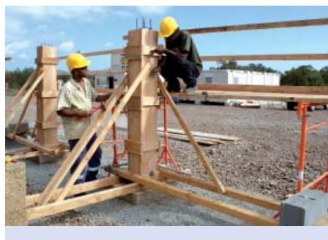
Stage de maçonnerie
