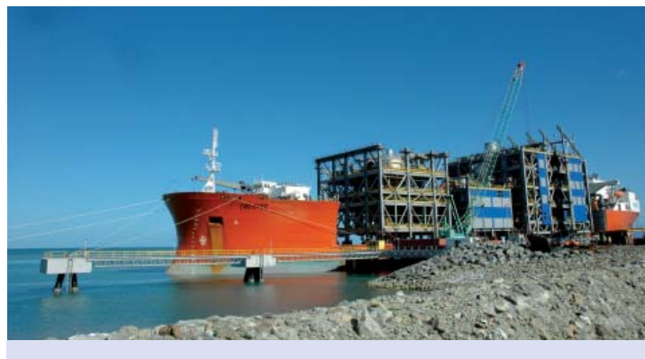
Arrivée des premiers modules en septembre
