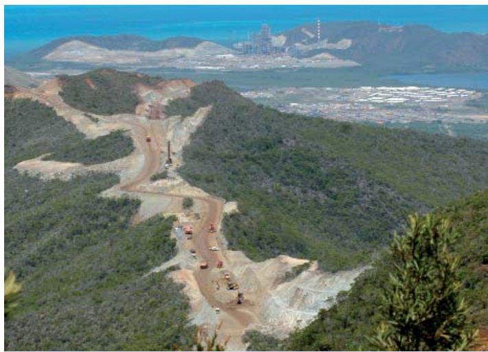
Travaux sur le massif du Koniambo
