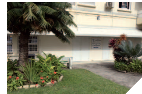
Antenne DAJAP Nouméa
