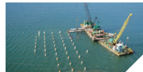
Quai de Népoui en construction
