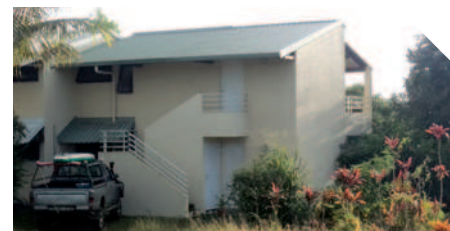
Logement provincial - Lotissement PAIAMBOUE
