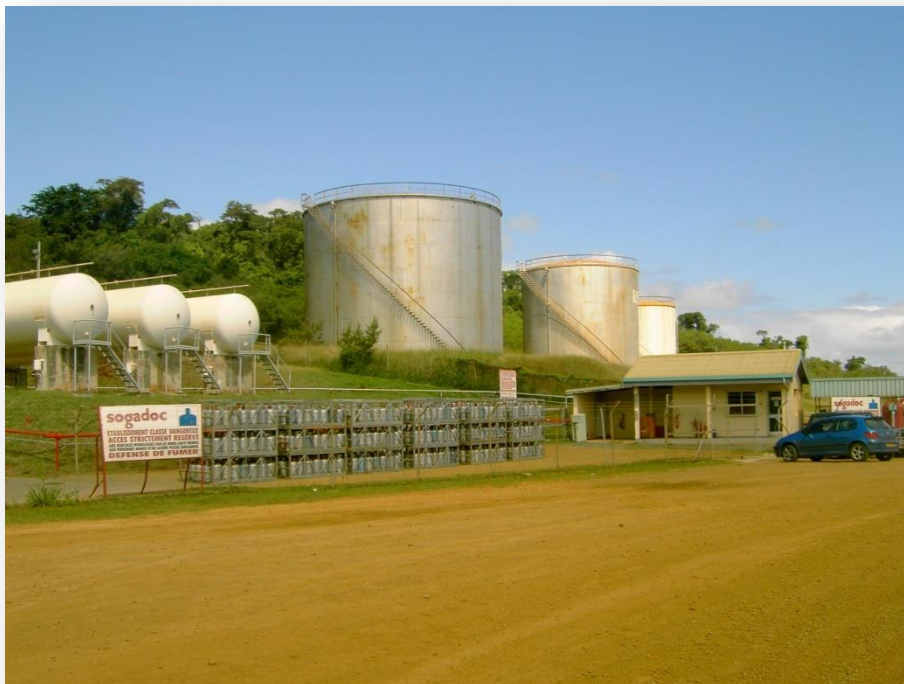
Photo 10 : Le centre emplisseur de gaz Sogadoc
