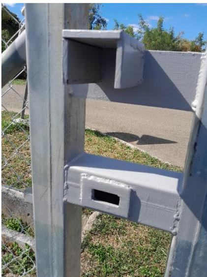
**Rail de guidage posé sur cornière : cornière 50 x 50 mm soudé sur fer plat scellé dans la longrine**
