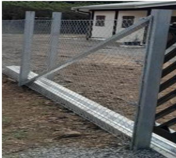
**Traverses intermédiaires en tubes acier carrées en acier galvanisé (barreaudage)**
