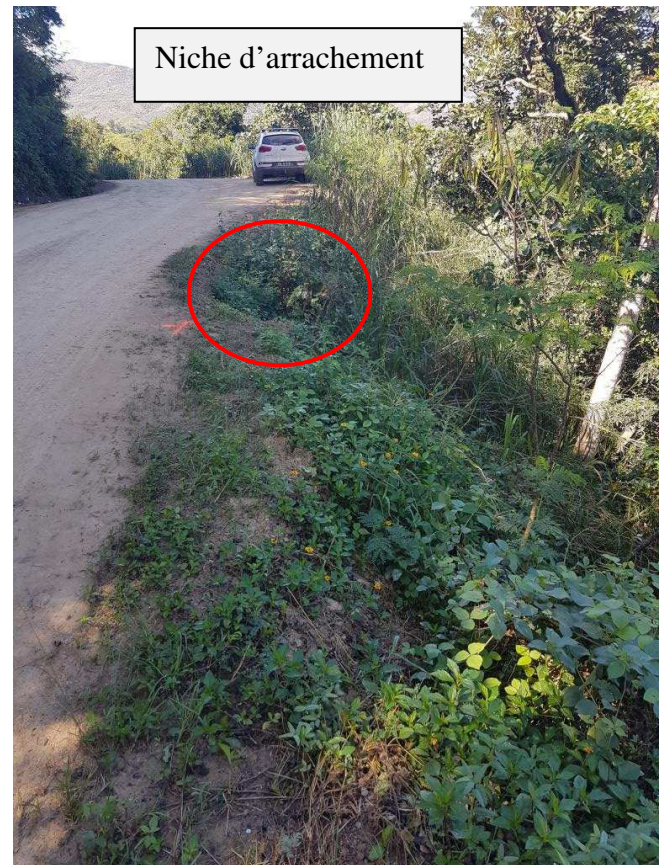
Photos 08 et 09 : Accotements et niche d'arrachement en sortie de virage.
