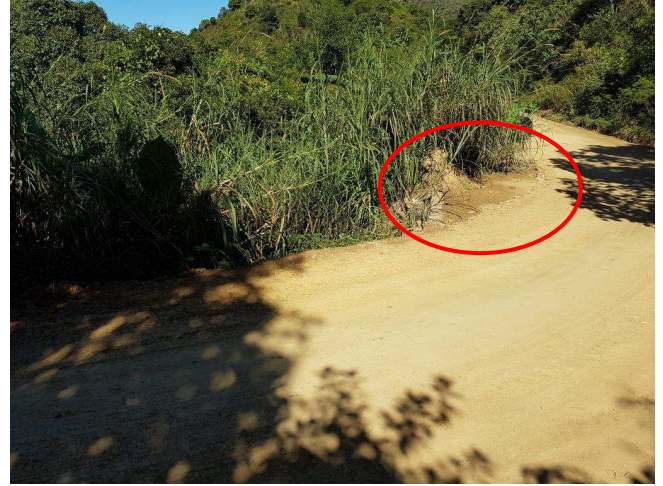
Photos 05 et 06 : Zone humide en tête du muret de soutènement.
