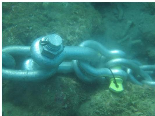
Figure 2 : Manille reliant la chaîne à l'ancrage écologique
