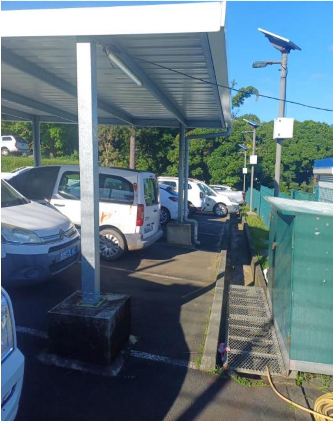
Traversée de l'enrobée sur 1,5m et remontée sur massif et poteaux / Possibilité de faire passer le câble en aérien.
