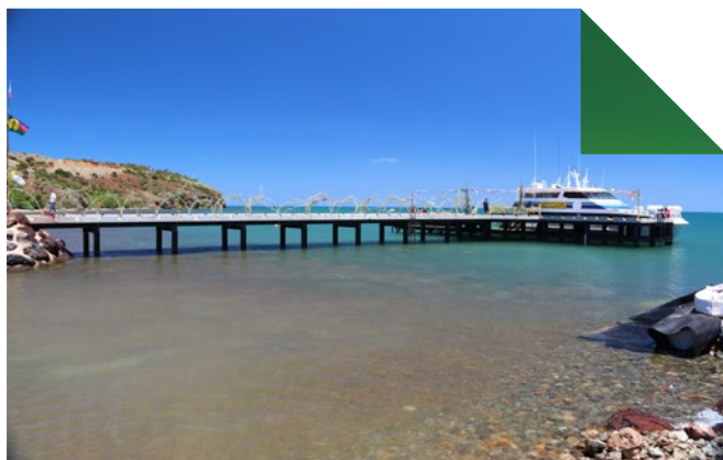
Seabreeze accosté au nouveau quai de Dau Ar (Bélep)
