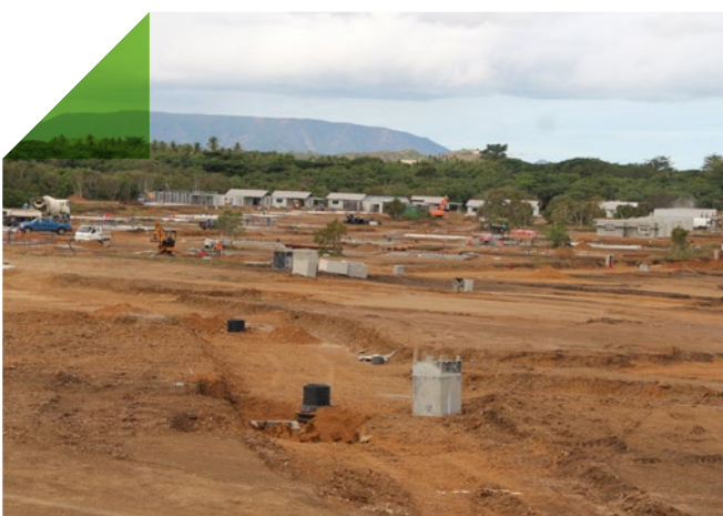
Réalisation du lotissement Gou Mee Wee à Koohnê (Koné)
