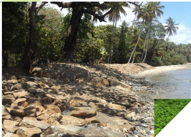
Aménagement du littoral à Hienghène pour contenir l'érosion
