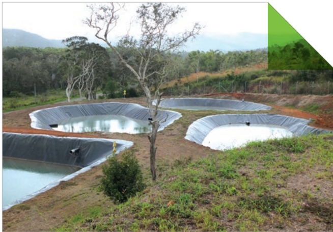
Lagunes de l'Installation de Stockage des Déchets (ISD) de Canala
