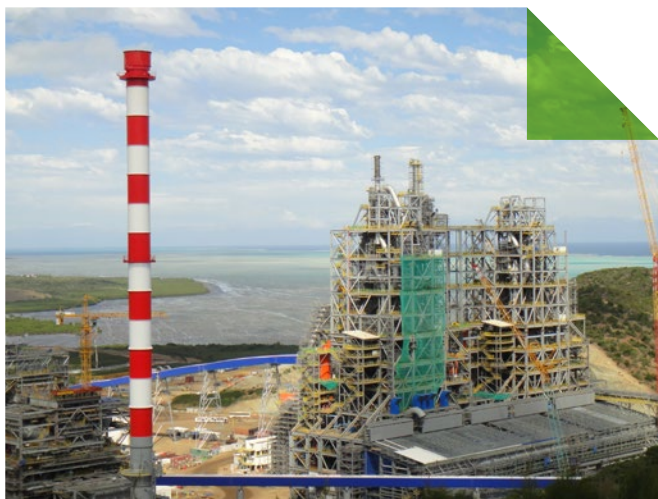
Usine du Nord en fin de construction
