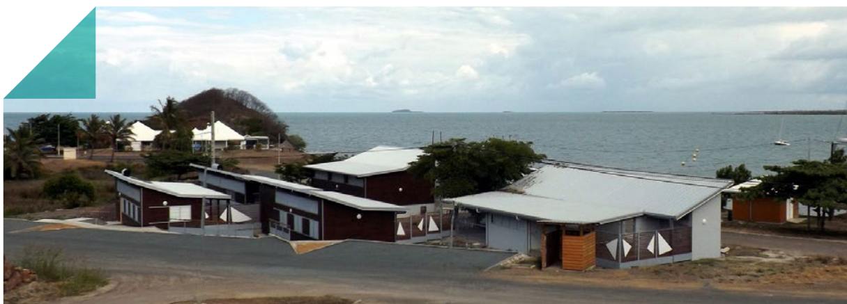
Un effort conséquent d'investissement a également été réalisé pour le sport (Base nautique de Pandop à Koumac)
