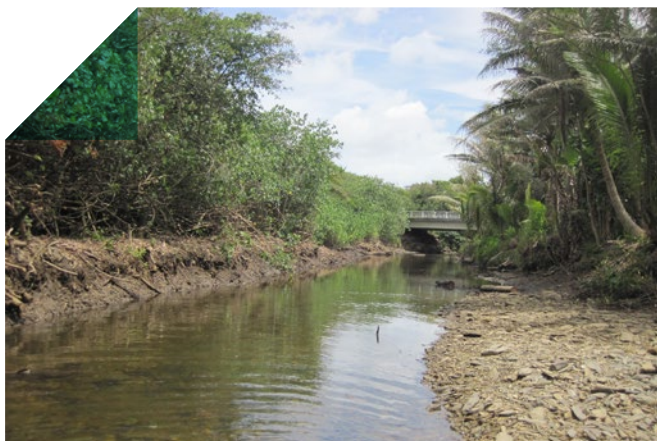
Travaux d'aménagement d'une rivière à Tuo Cèmuhi (Touho)
