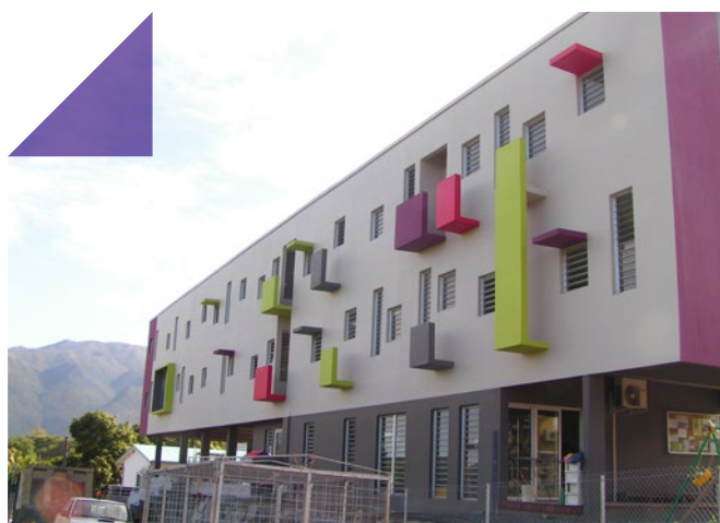
Nouveau bâtiment à l'école de l'Immaculée à Koohné (Koné)
