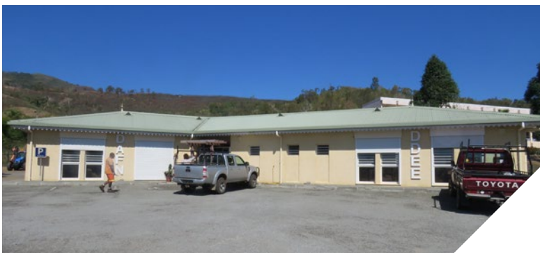
Nouveaux bureaux de la subdivision DAF et de l'antenne DDEE de Canala
