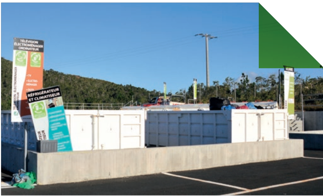
Déchetterie de Pum (Poum)
