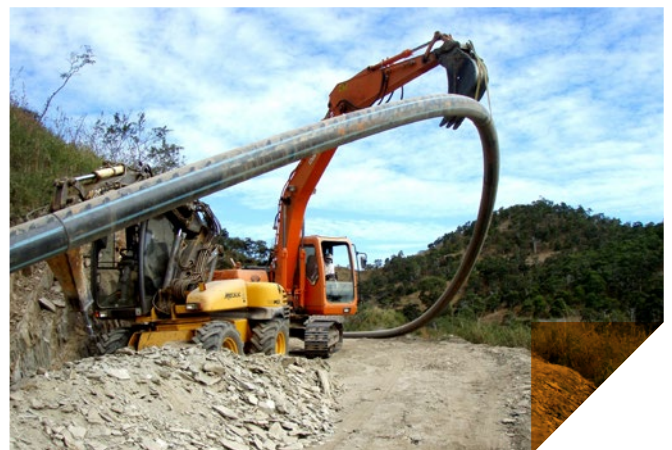
Pose de la conduite mixte AEP/irrigation du réseau de Waredi à Ouégoa
