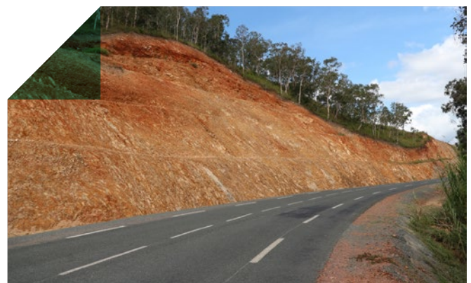
Les aménagements et ouvrages routiers représentaient le premier poste du PPI 2013-2016 (Travaux sur la RPN7)
