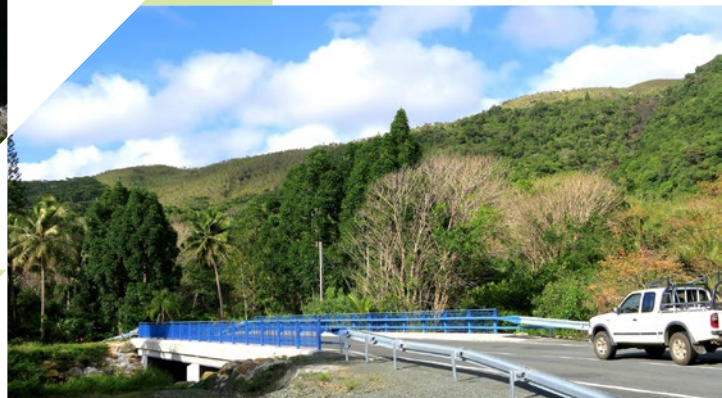
Nouveau pont de Petit Ko Cèi Goon (Kokingone)
