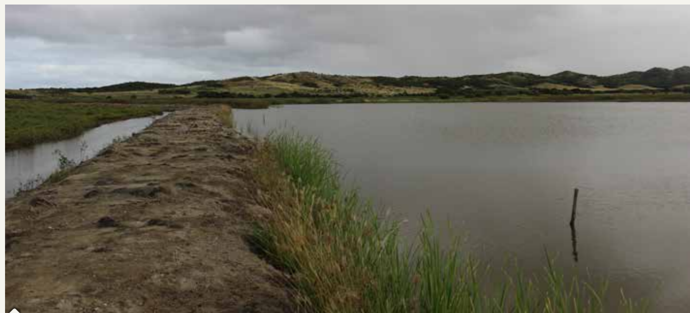
Digue de séparation entre l'eau salée et l'eau douce
