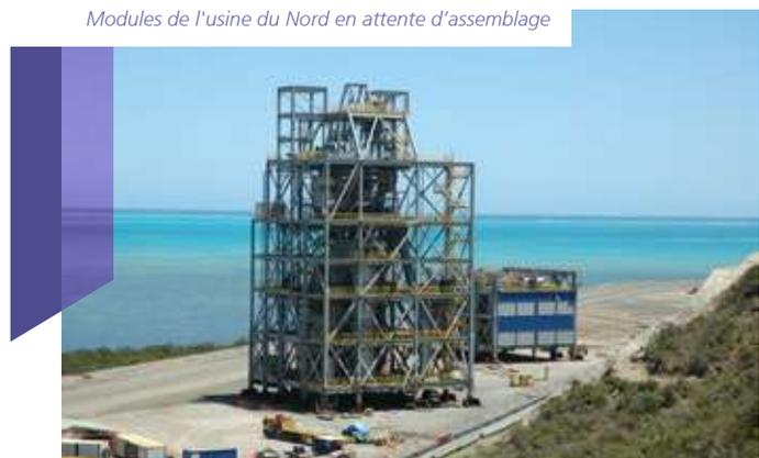
Modules de l'usine du Nord en attente d'assemblage
