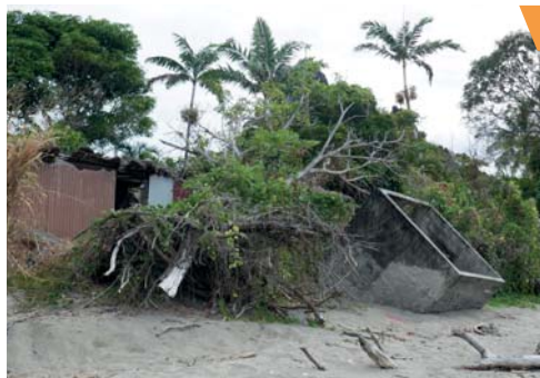
La salle de bains a basculé, la cuisine est partie avec l'eau, il n'en reste qu'un bout de carrelage... Le président de la République a pu constater les dégâts déjà subis par certains riverains du bord de mer.
