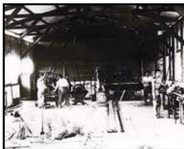
Atelier à Ouaco. Une locomobile à vapeur à deux volants entraîne par un palonnier et des courroies une perceuse radiale et une meule douce pour l'affûtage des outils. (Collection Kakou, ANC)
