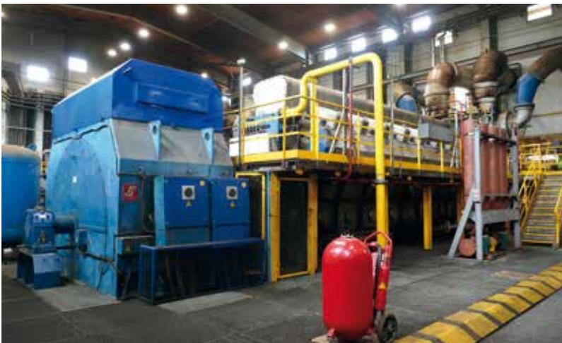
Quatre moteurs diesel assurent la production d'énergie. Pendant la journée, la centrale tourne souvent au minimum technique, soit 10% (6 mégawatts)
