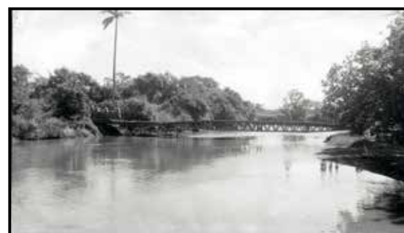
Un pont a été installé sur la Pouembout. (© Archives de Nouvelle-Calédonie)
