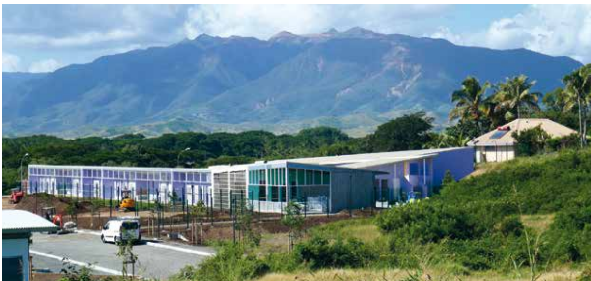
La construction de la nouvelle école maternelle s'achève. Les élèves devraient y faire leur rentrée après les vacances du mois d'août.
