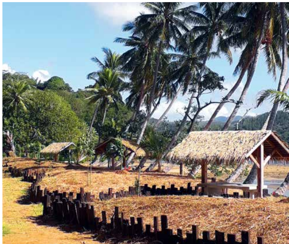
Des travaux sont en cours pour aménager une place publique au centre du village, en bord de mer. (Photo mairie Tuo Cèmuhi)
