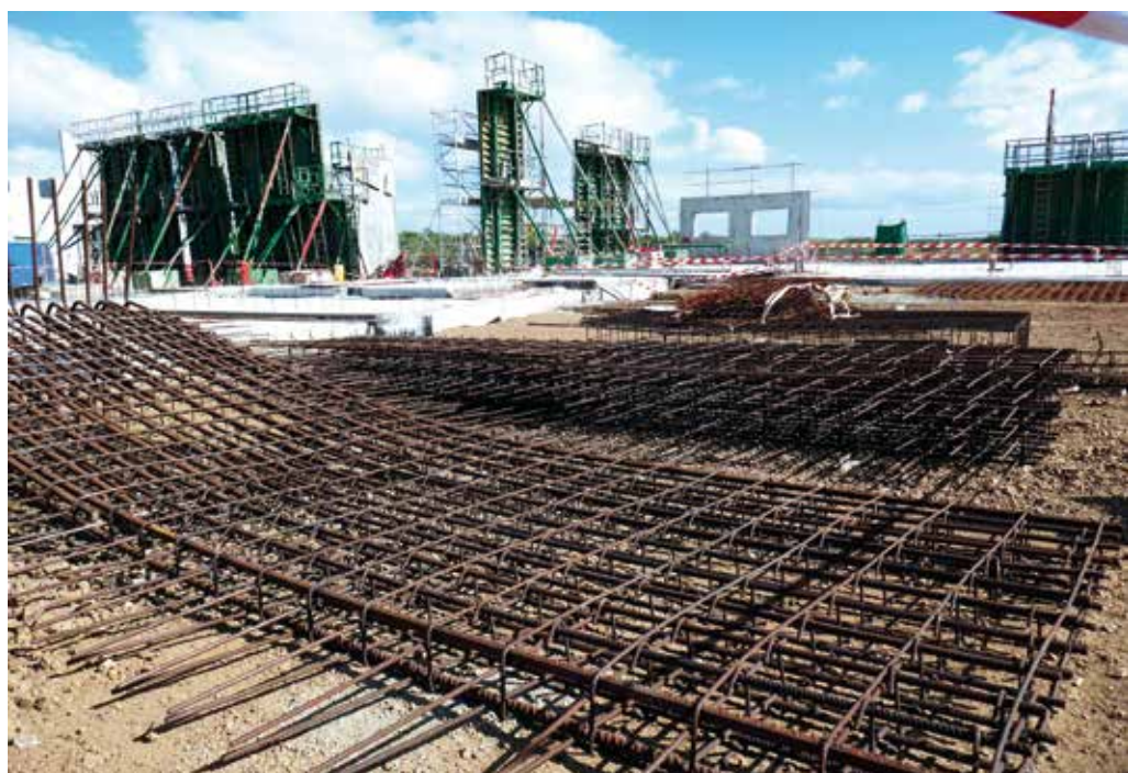
Vingt à trente entreprises sont impliquées sur le chantier.
