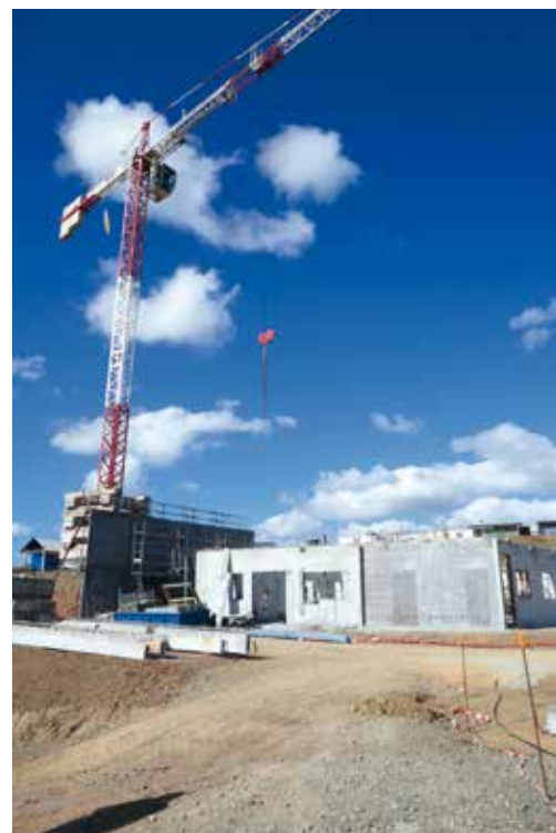
Après une première phase de terrassement, le gros-cœuvre a débuté depuis le mois de mai. La fin des travaux est prévue fin 2021 pour une ouverture début 2022.
