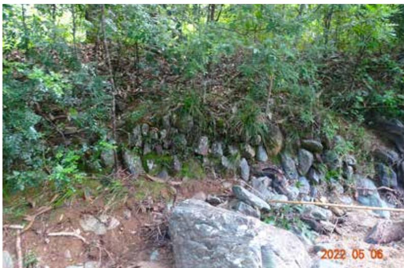
Mur de soutènement en pierres sèches construit pour maintenir la berge sous l'emplacement d'anciennes cases. (© DC)
