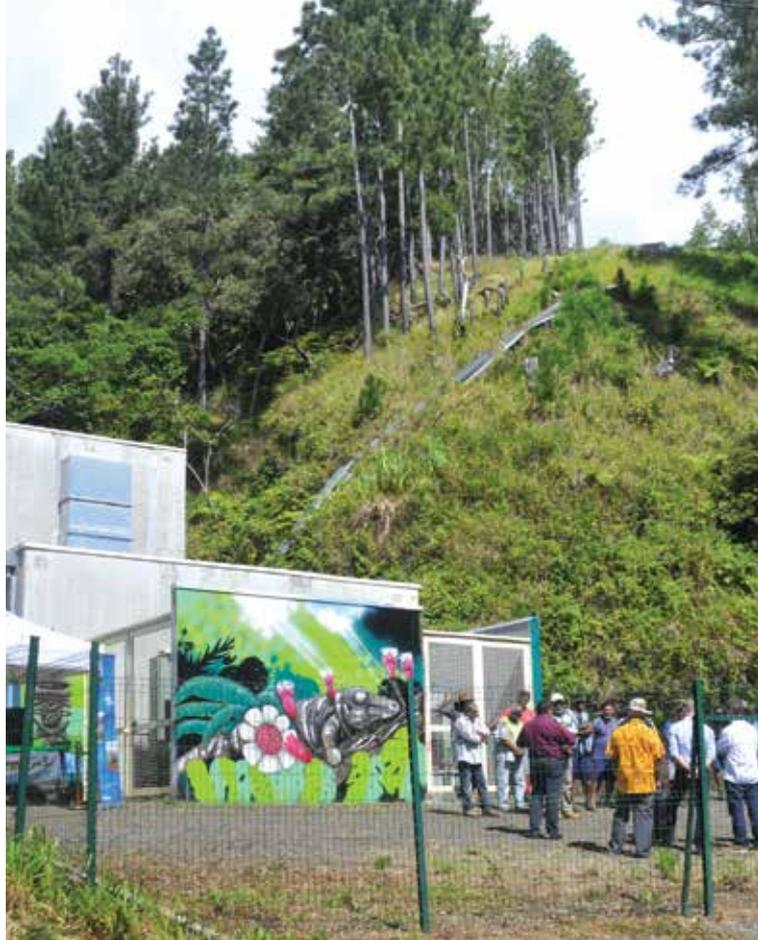
Depuis la prise d'eau à 560 mètres d'altitude, une conduite amène l'eau jusqu'à la centrale. C'est la hauteur de la chute et le débit de la rivière We Paalo qui permet la production d'énergie.
