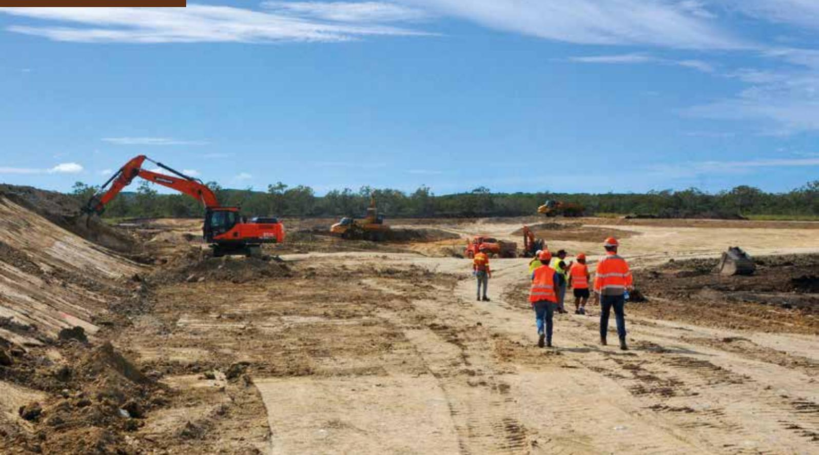
Une installation de stockage des déchets est en cours de réalisation sur la plaine des Gaïacs. Les déchets ménagers, préalablement triés en vue de recyclage, seront stockés dans une alvéole d'une capacité de 103 000 m<sup>3</sup>. On estime qu'elle pourra accueillir les déchets de la zone VKP et Poya pendant au moins 8 ans.
