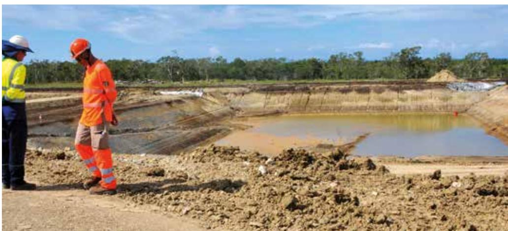
Le principe de ce type d'installation de stockage des déchets est d'empêcher tout rejet dans la nature. Les « jus » produits par la décomposition des déchets passent par un bassin de décantation puis un bassin de phyto-épuration.
