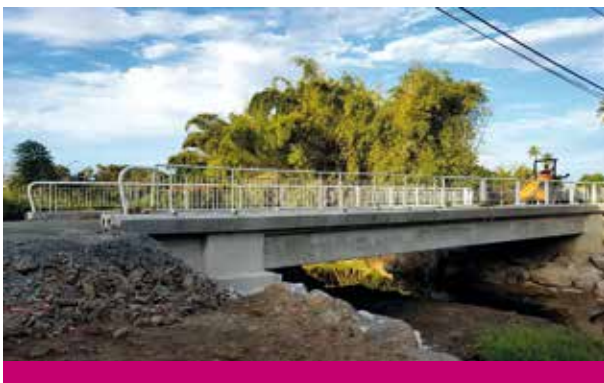
Pont de Nonhoué à Canala
