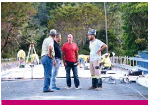
Visite du chantier du pont de Grand Ko Cèi Goon (Kokingone)
