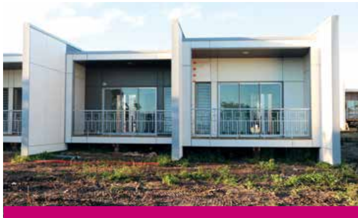
Maison d'accueil hospitalière à Koehné (Koné) en construction
