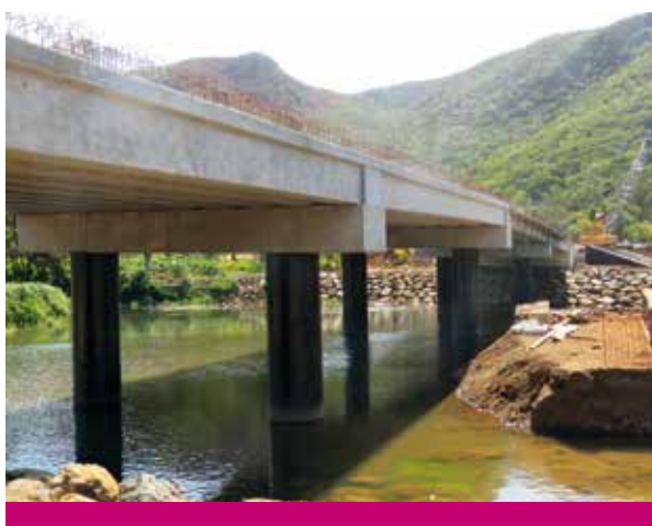
Pont de Ouéna à Kaa Wi Paa (Kouaoua) en construction
