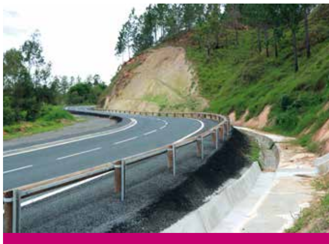
Réfection du col de Bopope
