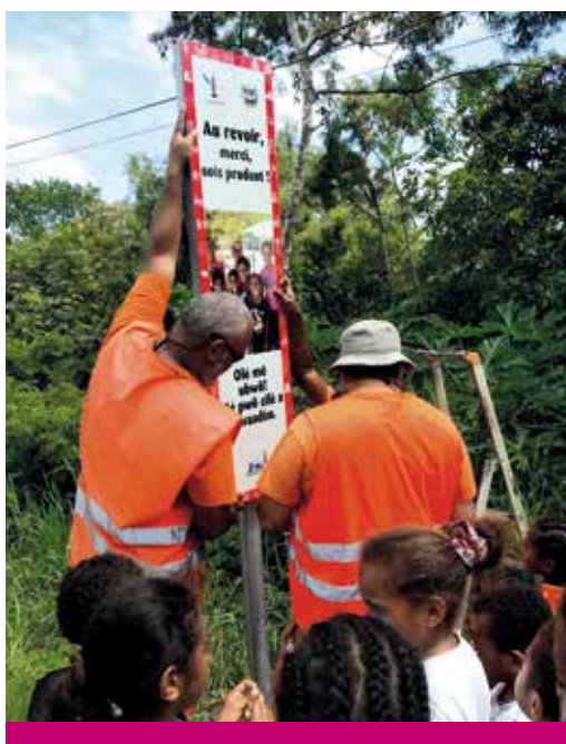
Pose des panneaux pour la sécurité routière à Koé
