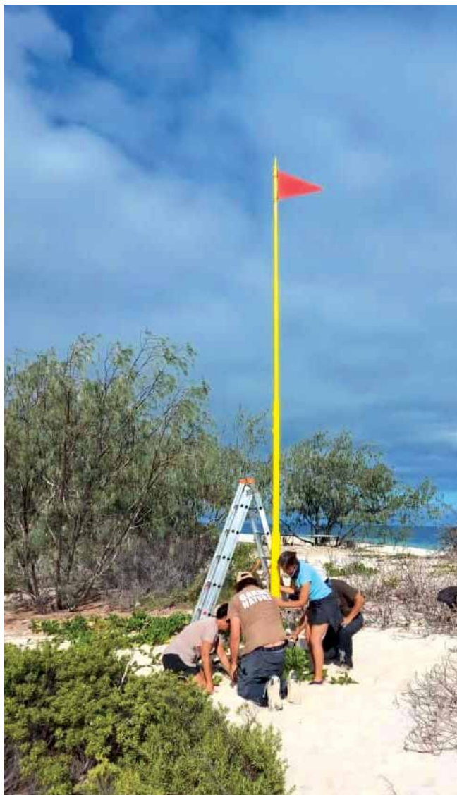
Installation d'un mât d'avertissement sur un îlot à Koumac
