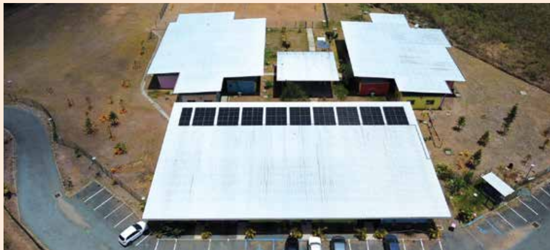
Equipement photovoltaïque de la maison de l'enfance de Koohnê (Koné)
