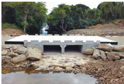
Reconstruction du radier de Weyeeep à Pweevo (Pouébo)
