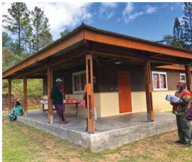
1600 ème maison du programme « habitat en Province nord »
