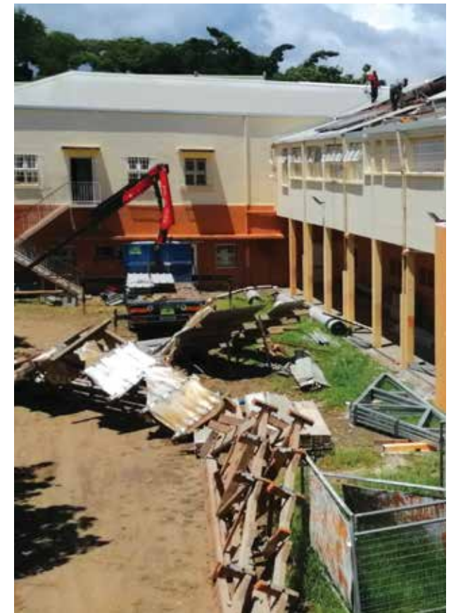
Rénovation de l'internat de Koumac
