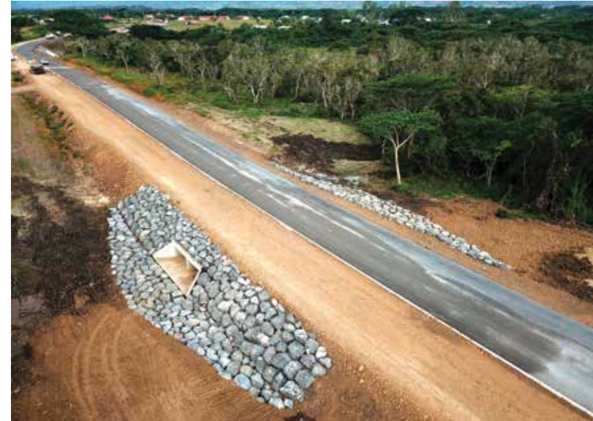
Nouvelle route du lycée à Pwëbuu (Pouembout)
