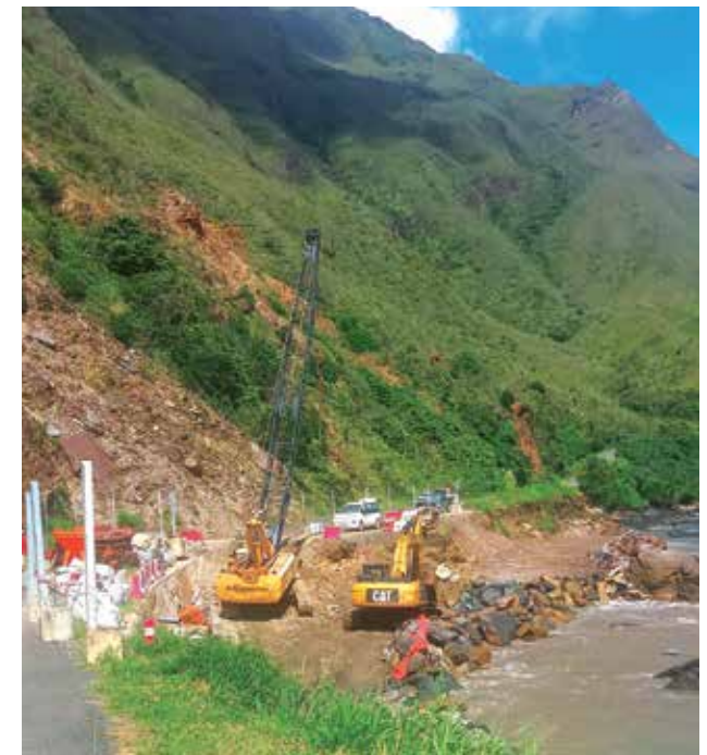
Confortement de la route de la corniche de la Ouaième
