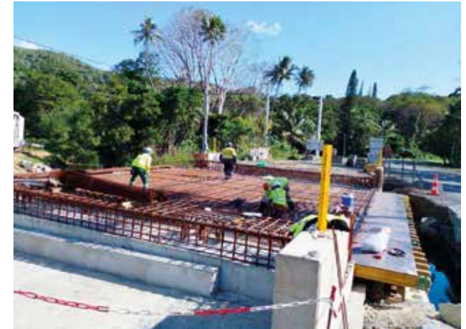
Construction du pont Tipwaditu à Tuo Cèmuhi (Touho)
