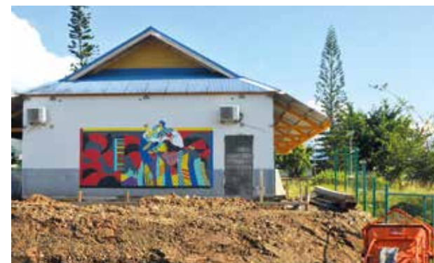
Travaux au collège de Koohné (Koné)
