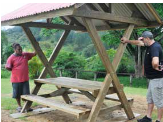
Réaménagement d'une aire de repos
