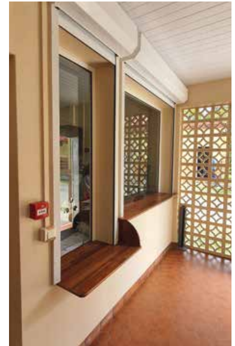
Rénovation de l'accueil du CMS de Pweevo (Pouébo)
