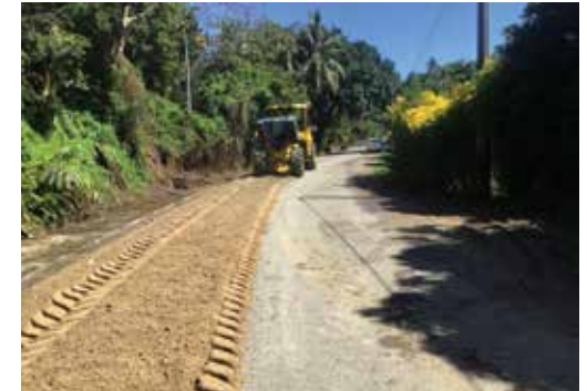
Travaux routiers sur la RPN 10 à Ouenpoues
