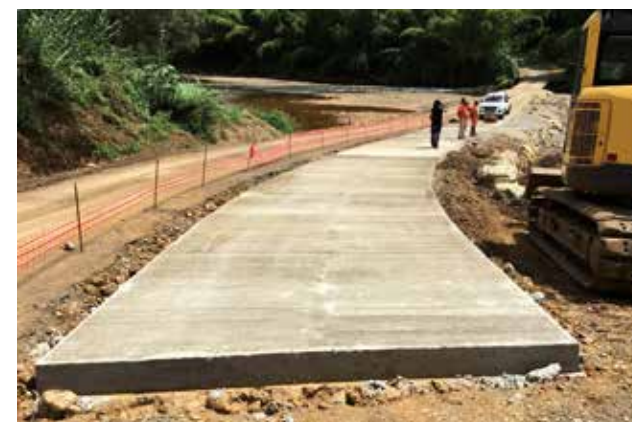
Réfection de l'accès à la passerelle de Mére (RPN3)
