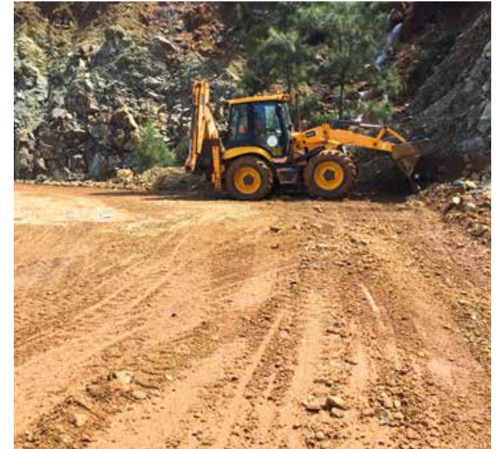
Déblaiement d'une route après des intempéries
