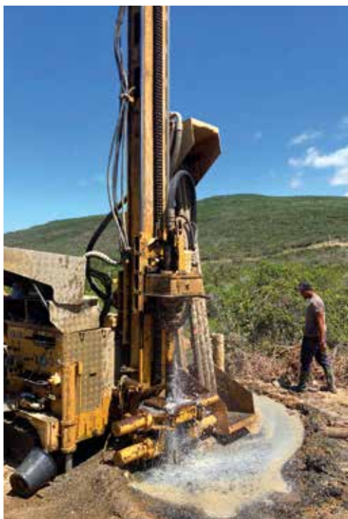
Réalisation d'un forage à Koumac
