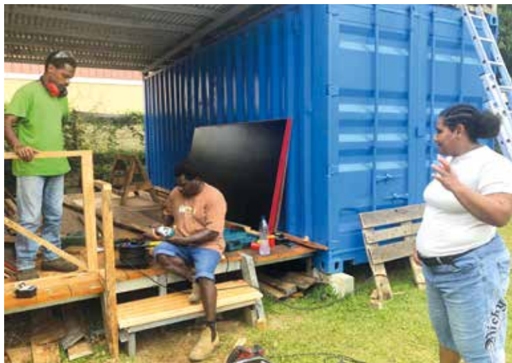
Un atelier menuiserie est en cours d'aménagement entre deux containers.
