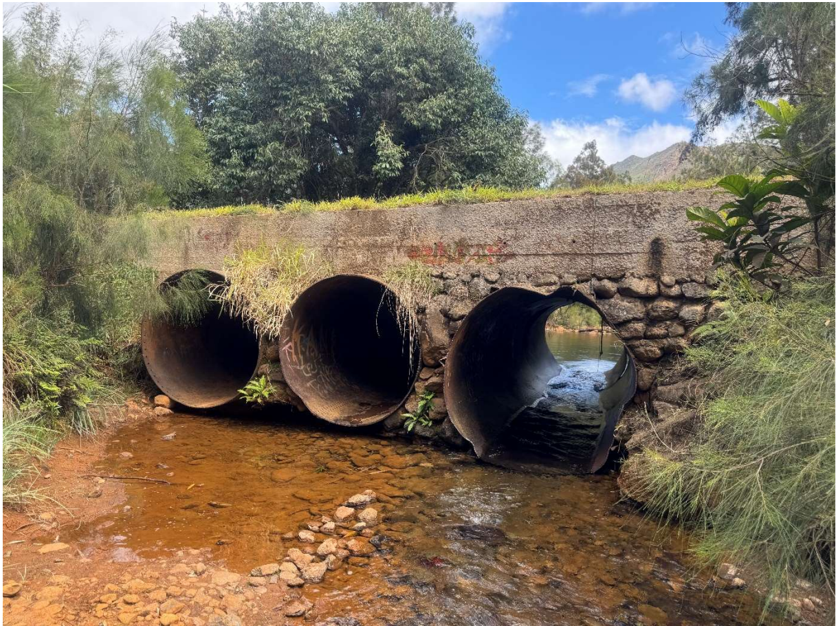
Photo de l'ouvrage : vue depuis l'amont
