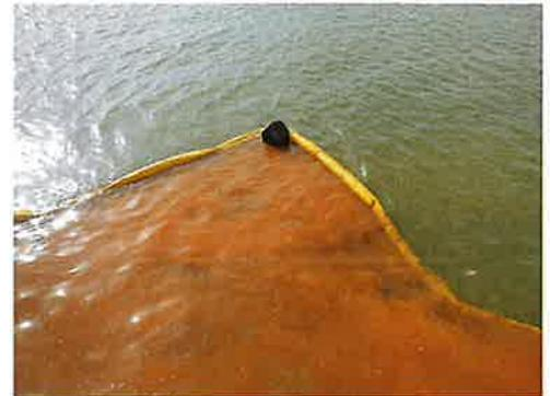
Ces barrières anti-sédiments permettront de contenir la majeure partie des fines. L'entretien régulier des filets sera assuré afin que ce dernier remplisse pleinement son rôle sur la durée.
