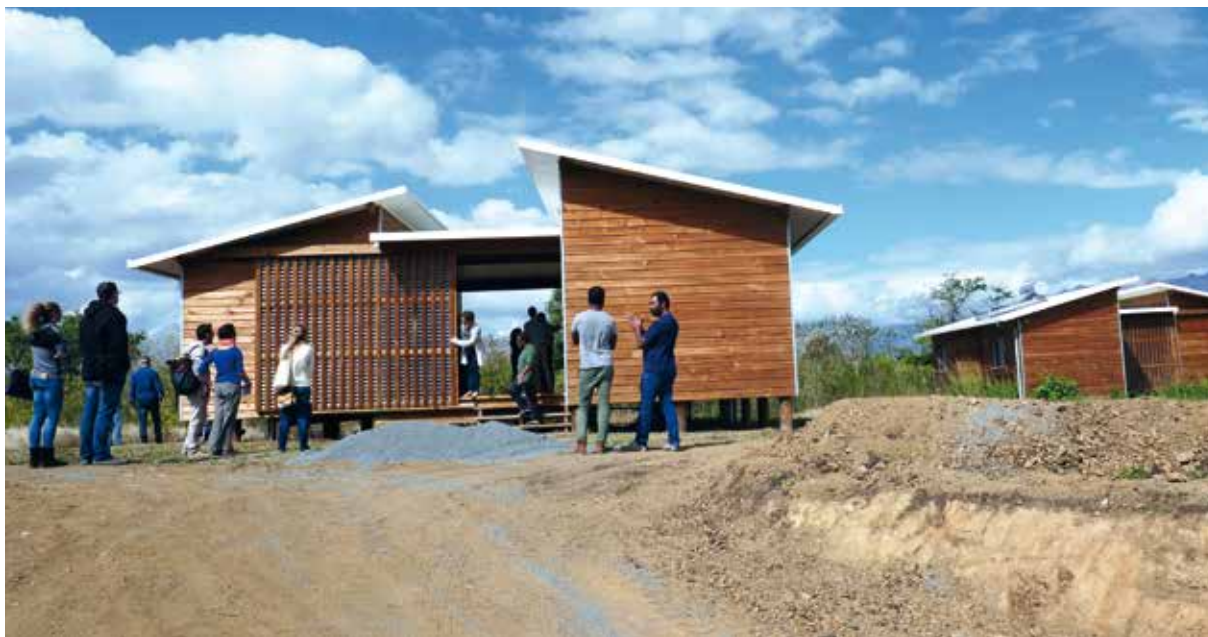
La rencontre du Club climat du 9 septembre s'est terminée par une visite de projets-pilotes, au collège de Païamboué, établissement construit en béton de terre, puis à Pouembout, dans un lotissement du FSH. Les visiteurs ont pu apprécier la ventilation naturelle dans ce « pavillon tropical » conçu par un groupement réunissant l'architecte Claire Lallié et Bois du Nord, fabriqué avec du bois local en provenance du plateau de Tango.
