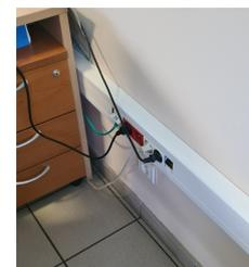
Locaux et recepteurs électriques **50 Réaliser ou améliorer la continuité de la liaison au conducteur de protection de la multiprise alimentant micro onde et réfrigérateur (valeur maximale de 2 ohms).**
